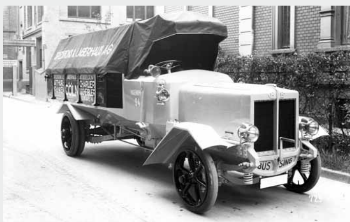
Büssing Typ II (1914): Erster Lkw mit Kardan, elektrischen Frontscheinwerfern und Gas-Positionslampen. Photo: MAN
