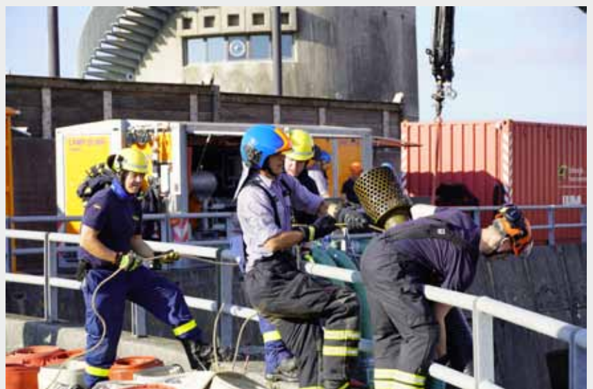
Gemeinsam wird der schwere Schlauch mit verbundenem Saugkorb aus dem Wasser gehoben. THW/Emanuel Jaschko
