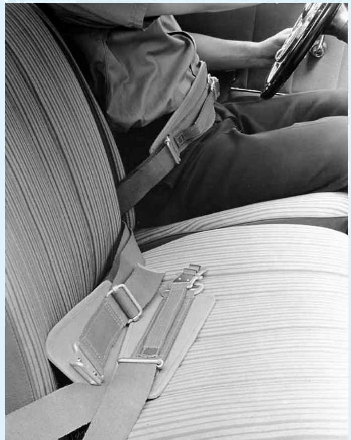
Sicherheitsgurte in einfachster Ausführung für Fahrer und Beifahrer aus dem Jahre 1958
