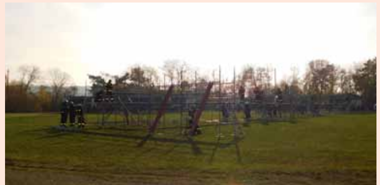
Der Hochwassersteg in der Entstehung
