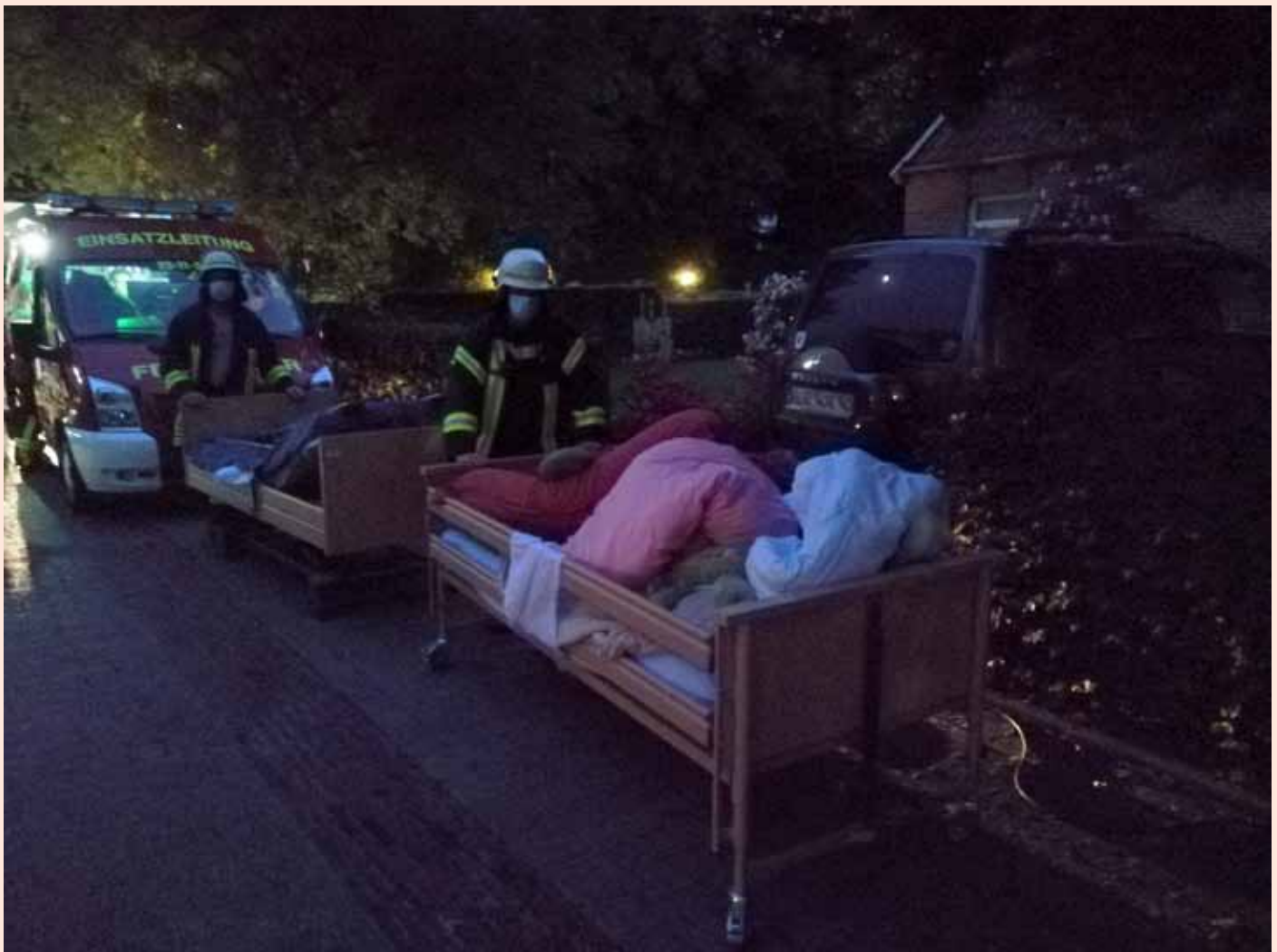
Herabgestürzte Zwischendecke in Wohnstätte für Menschen mit Behinderungen in Bedekaspel. Einsatzkräfte unterstützen bei der Bergung von Pflegebetten.
