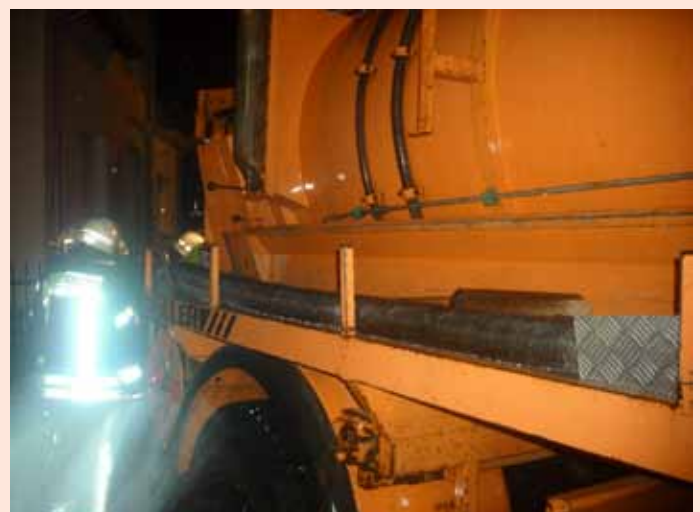
Der Spülwagen sorgt immer wieder für freien Abfluss
