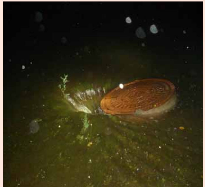
Wasserabfluss nach Öffnung des Schachtdeckels
